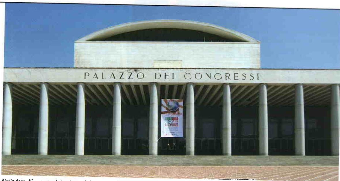
Nella foto, l'ingresso del palazzo dei congressi dell'Eur. Nella pagina precedente e nelle seguenti, immagini dei lavori della Convention e il passaggio delle consegne tra Carlo Mearelli, presidente uscente, e il nuovo presidente, il cinese Shen Shaoji.
